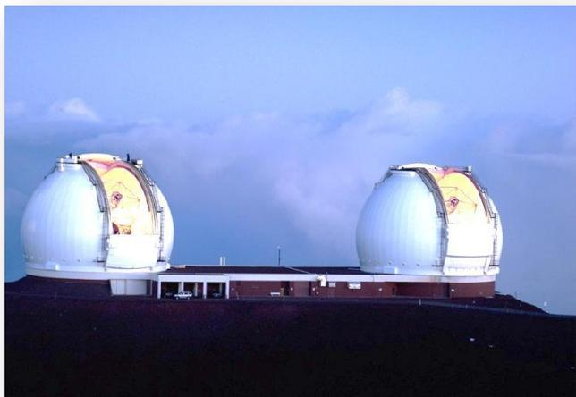
dessous. Séparés de 85 m, ces télescopes géants ont été installés au sommet du volcan Mauna Kéa, à une altitude de plus de 4 000 m. Chacun a un miroir primaire hyperboloidal de 10 m de diamètre
